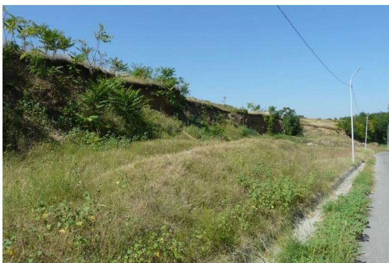
Figure 23Foto 7 – versant afectat de fenomene de instabilitate
