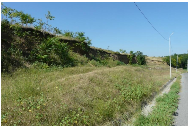
Fig. 34 Foto 7 – versant afectat de fenomene de instabilitate
